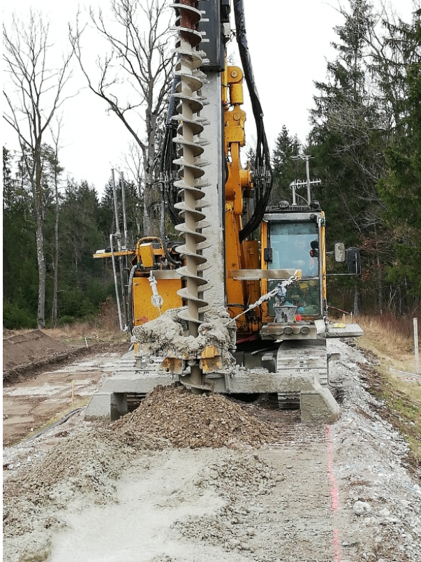
Abb. 1: Schwerggerät beim Einbau der Erdbetondichtung
